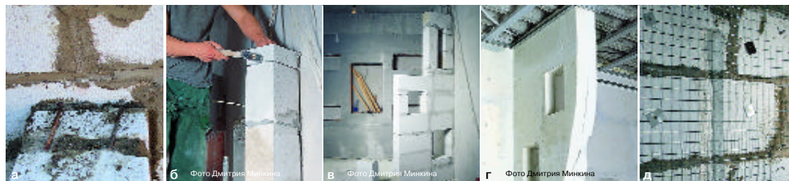
а) Концы арматуры закрепляют в несущие конструкции здания (стены)
